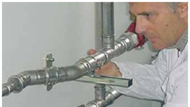
Fig 33 - Kontroll av press anslutningen
