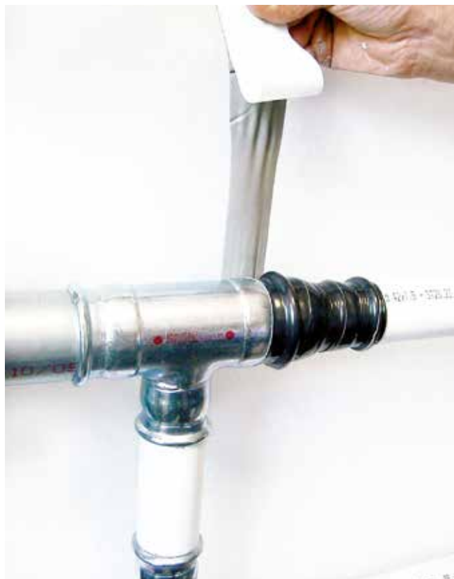
Fig 35 – Skydd av anslutningar med butanol vidhäftande tejp
