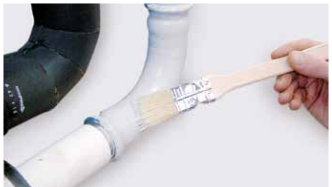
Fig 34 - Stryk anslutningar och rör med primer.
