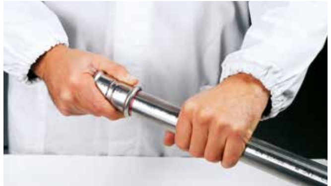
Fig 31 - Insättning av röret i presskopplingen
